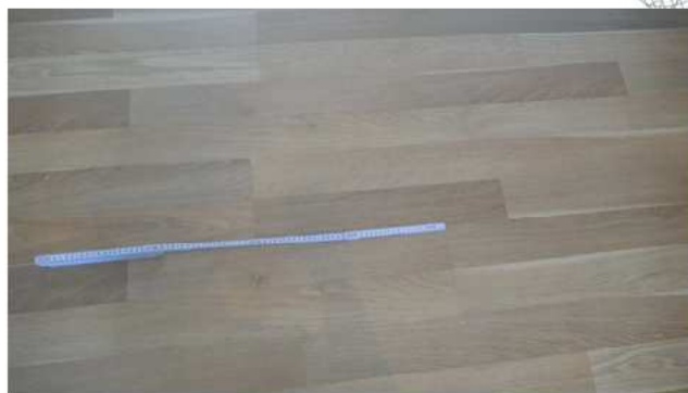
På det meste av gulvet er det langt større avstand mellom skjøtene.
