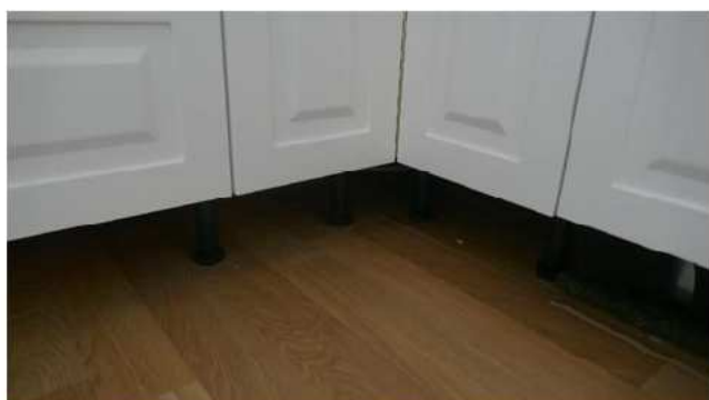
Kjøkkeninnredning står montert rett på laminaten og bidrar til å hindre fri bevegelse.
