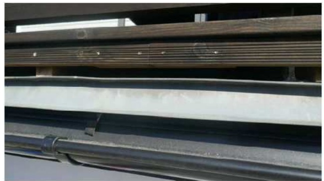
Det er eldre tekking av sink på taket over inngangsparti.
