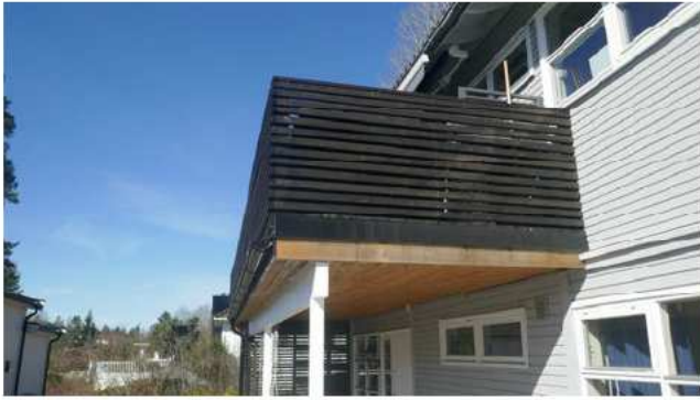
Tak med eldre tekking over inngangsparti.
