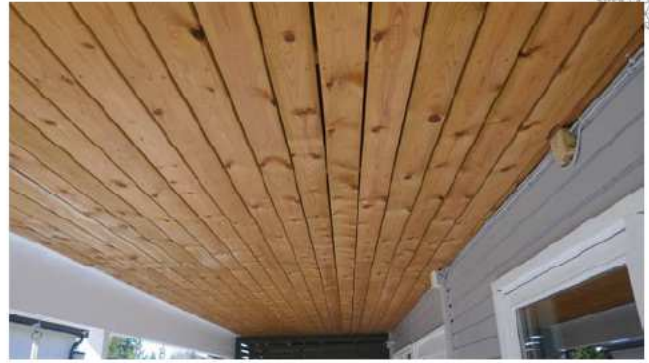
Det er ikke observert tegn til skader i panel under taket frem til drager.
