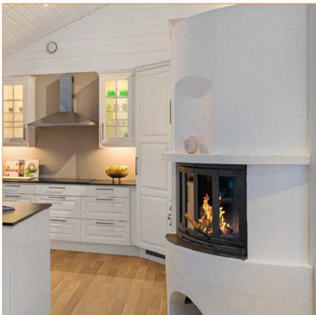
Eier opplyser at det trekker dårlig fra ildsted. Bildet med flammer er fra salgsoppgave.
