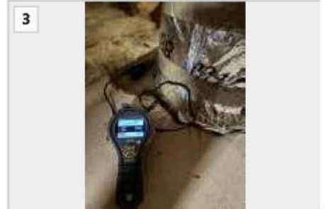
Fuktsøk. Det ble utført fuktsøk med pigger som viste en fuktvekt på 39,8%.
