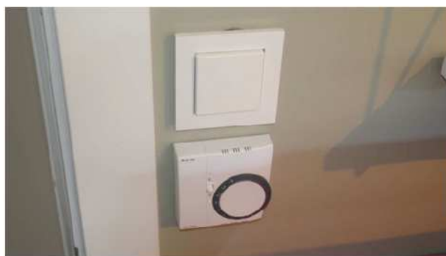
Mindre utetthet mellom bryterdeksel og boks.
