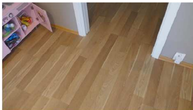
Laminaten er lagt gjennom døråpning uten overgangslist.
