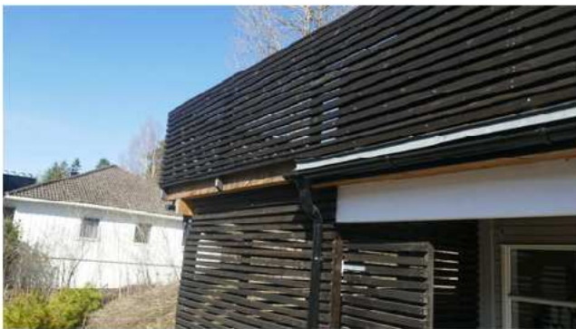
Skillet ved opprinnelig tak går ved avslutningen på takrenna.
