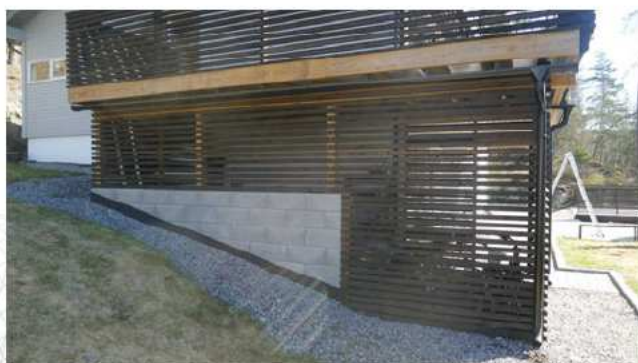
Bod og mur med synlig plast.
