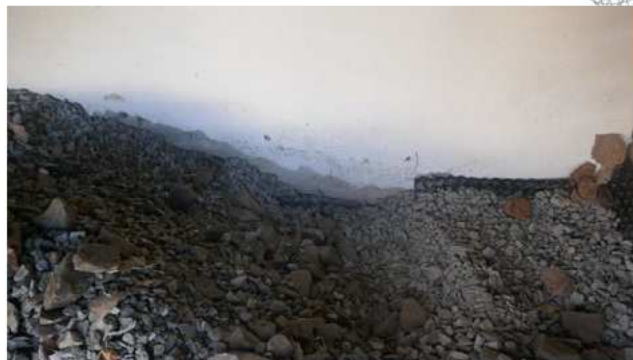
Ved å krafse vekk pukk, fant jeg plast noe lenger ned.
