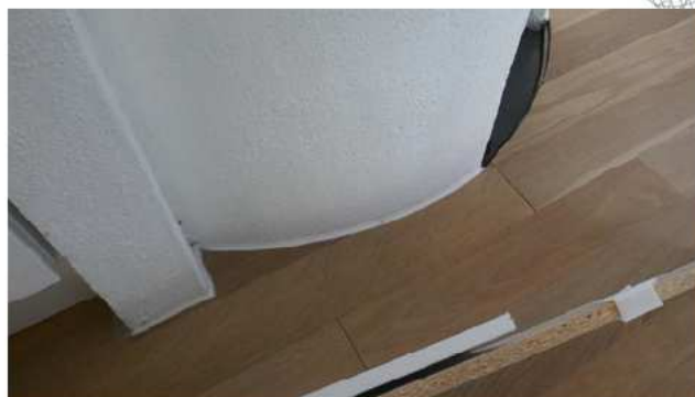
Utstrakt bruk av fugemasse.
