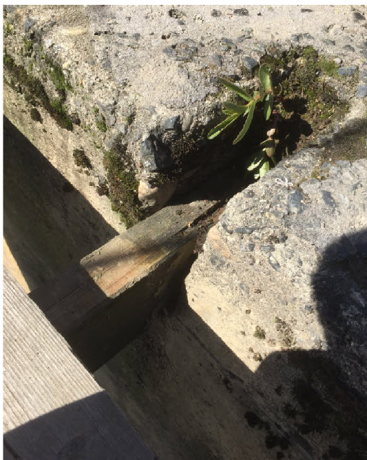
Bjelkeinnfesting på brokar landside.
