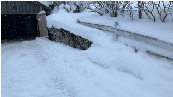
Forstøtningsmurer er snødekt og derfor ikke nærmere vurdert.
