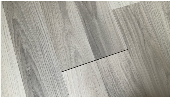
Glipper i laminatgulv.
