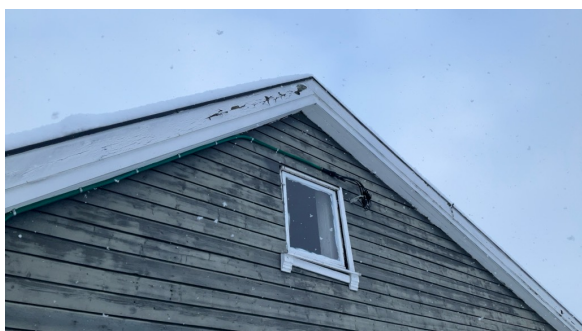
Vindskier bærer preg av elde og slitasje.
