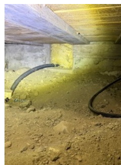
Synlige deler av kryperom fremstod som tørr og luftig på befaringsdagen.
