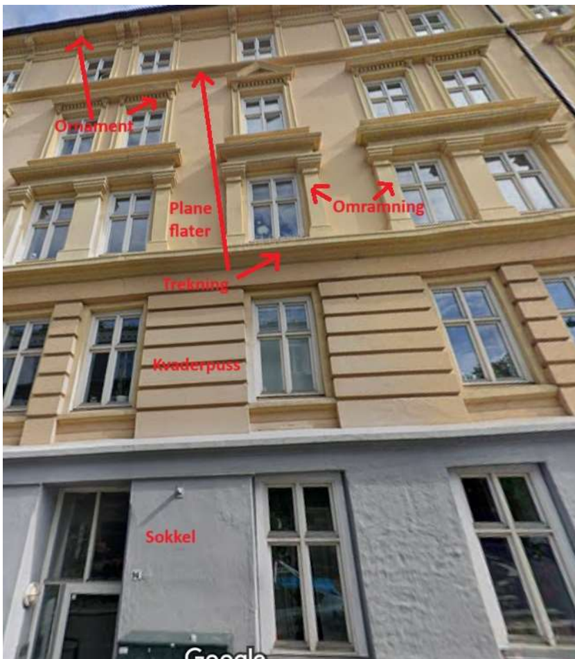
Bilde 1: Oversikt over fasade og de ulike bygningsdelene.
