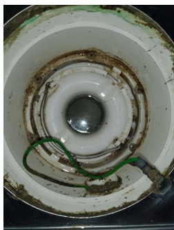
Tettesjiktets tilslutning til sluk - Sluk
