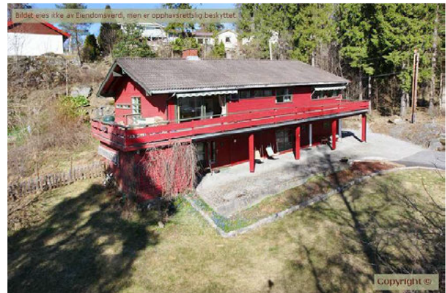
Bilde fra eiendomsverdi 2011 viser opprinnelig terrasse med tekking på undersiden. Det er også bod på undersiden, slik som i dag.
