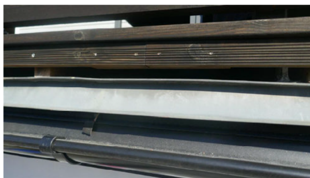
Det er eldre tekking av sink på taket over inngangsparti.
