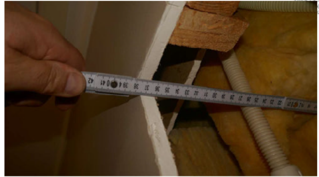
Veggen er så tykk at det ville ikke gi noen nyttig info å bore hull i vegg for kontroll. Veggen er også åpen, slik at måling av relativ luftfuktighet ville ikke gi korrekte resultater.
